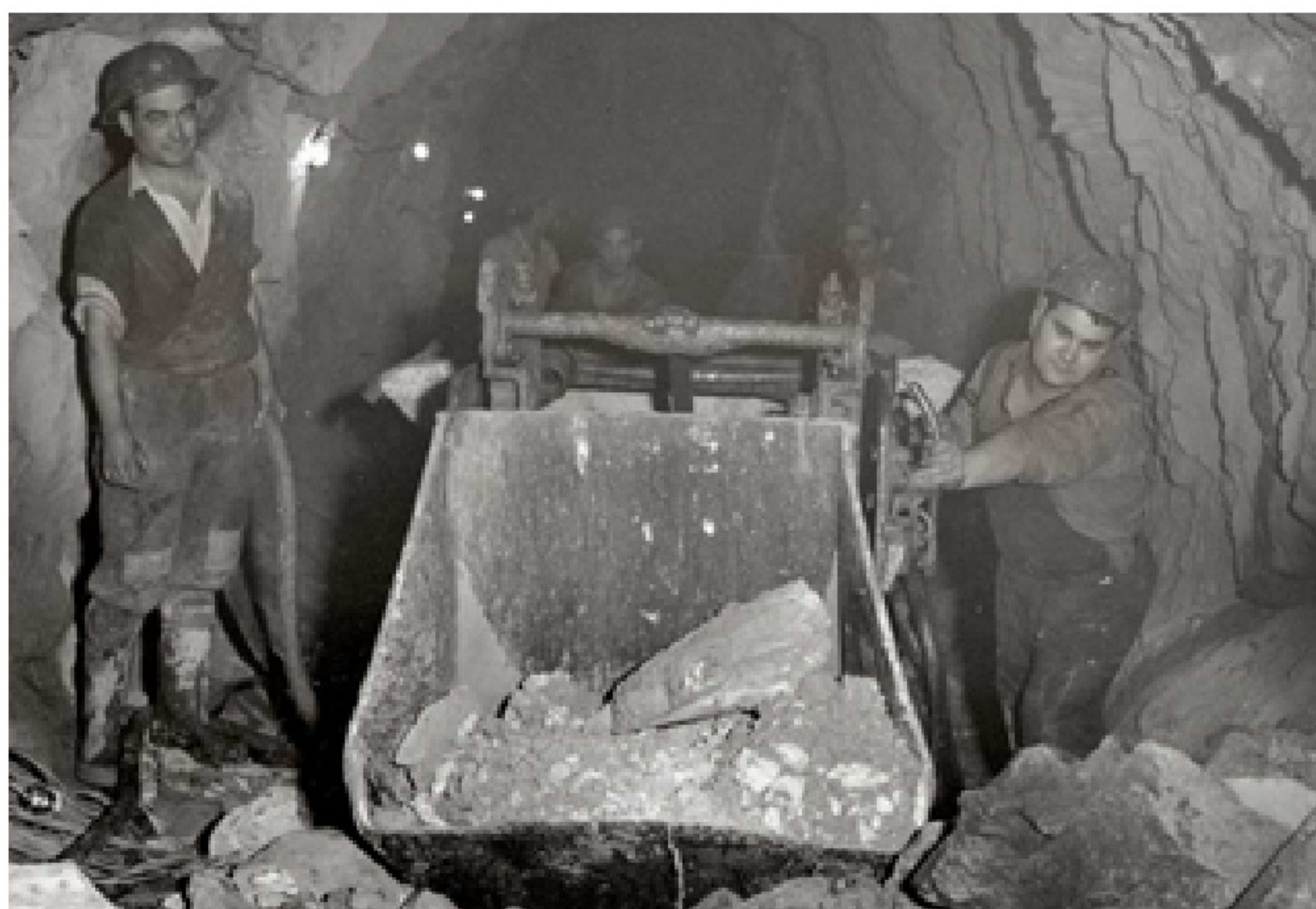
Pun-laboristoj dum la konstruado de tunelo
