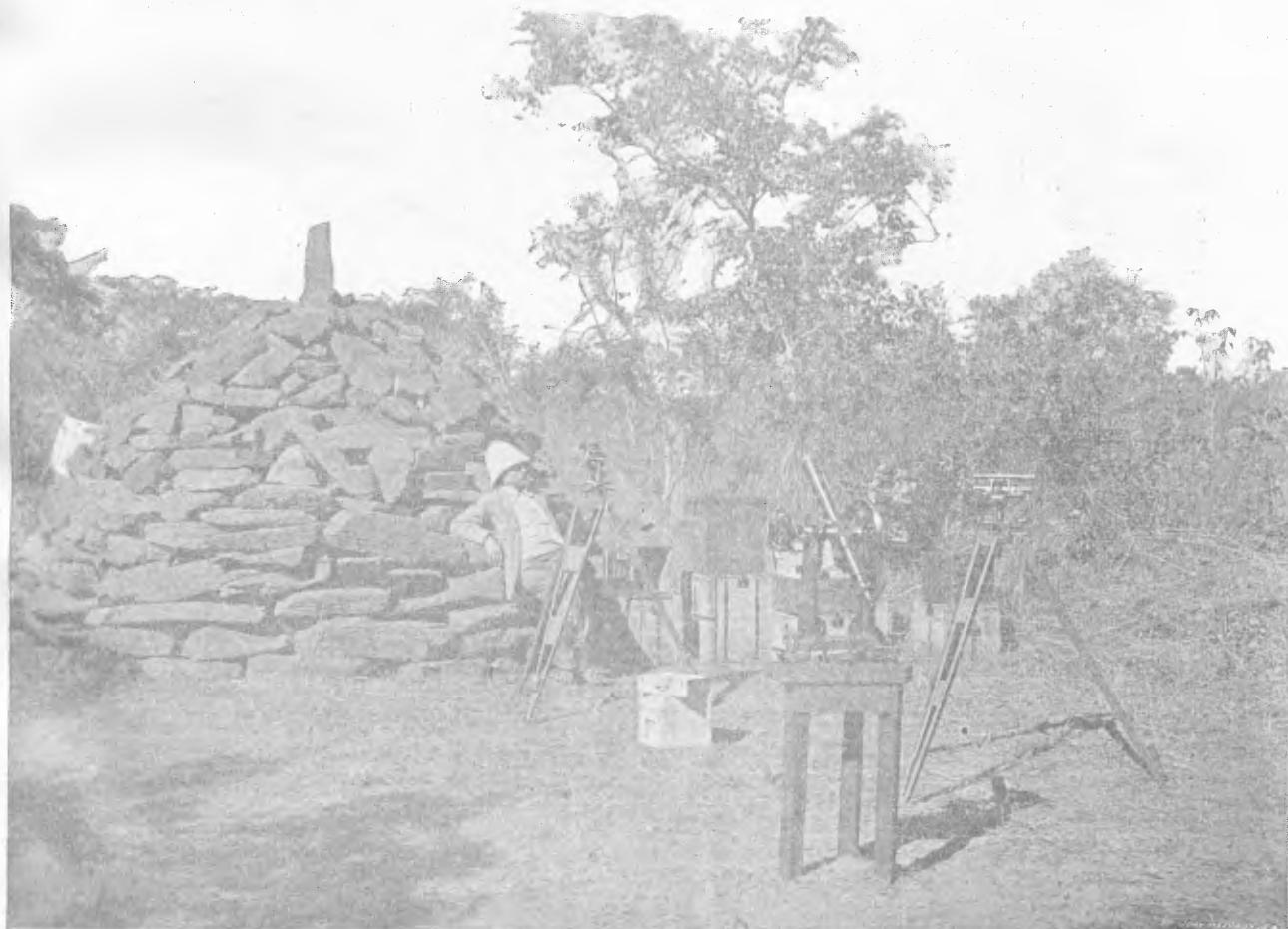
est destiné à déterminer les 3 composantes magnétiques, savoir la déclinaison, l'inclinaison et l'intensité horizontale. Cet instrument s'appelle un magnétomètre ; il est, ici, monté en intensimètre.
