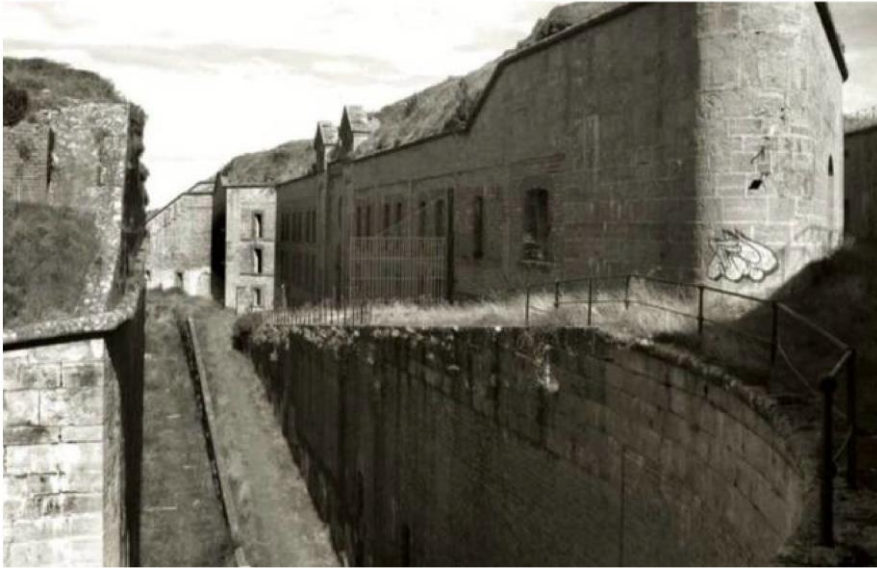
Imagen de época del interior del fuerte. Espacio entre el edificio de pabellones (izda) y la capilla (dcha).
