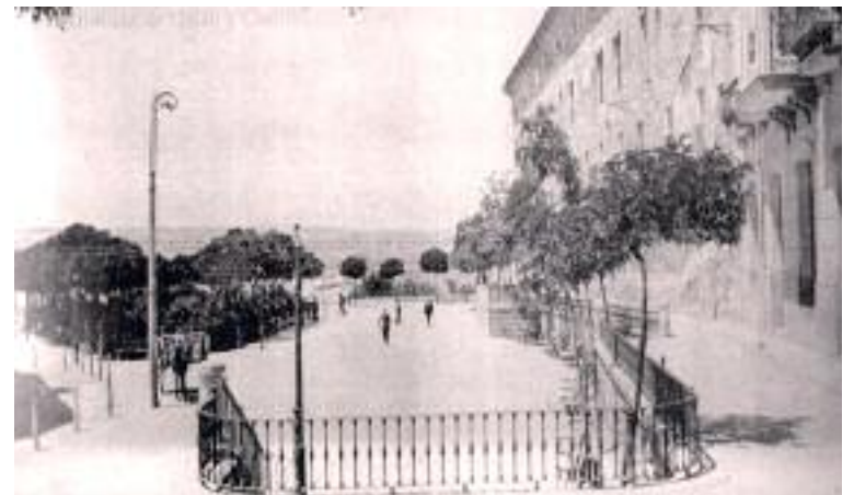
Sede 1º del Instituto General Técnico en el convento de Dominicos
