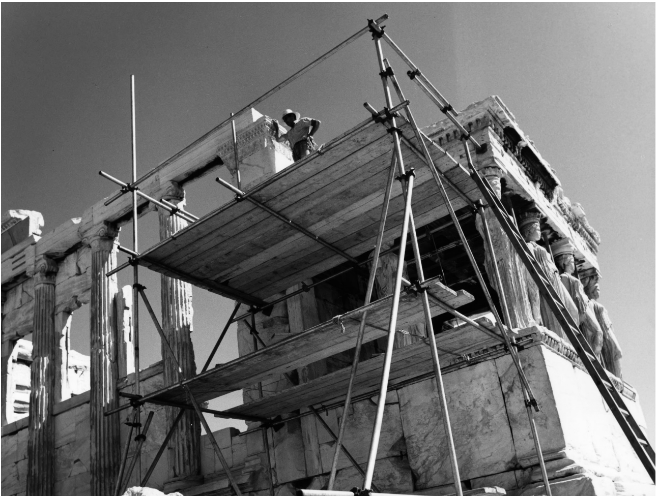
Restarigo de la verando de la Kariatidoj ĉe Erechtheion, 1968. En 1977, UNESKO lanĉis kampanjon por la restarigo kaj konservado de la Akropolaj Monumentoj, kiuj estis detruitaj de jarcentoj da milito, tertremoj, fajroj, akvodamaĝo, aerpoluado kaj amasa turismo.
