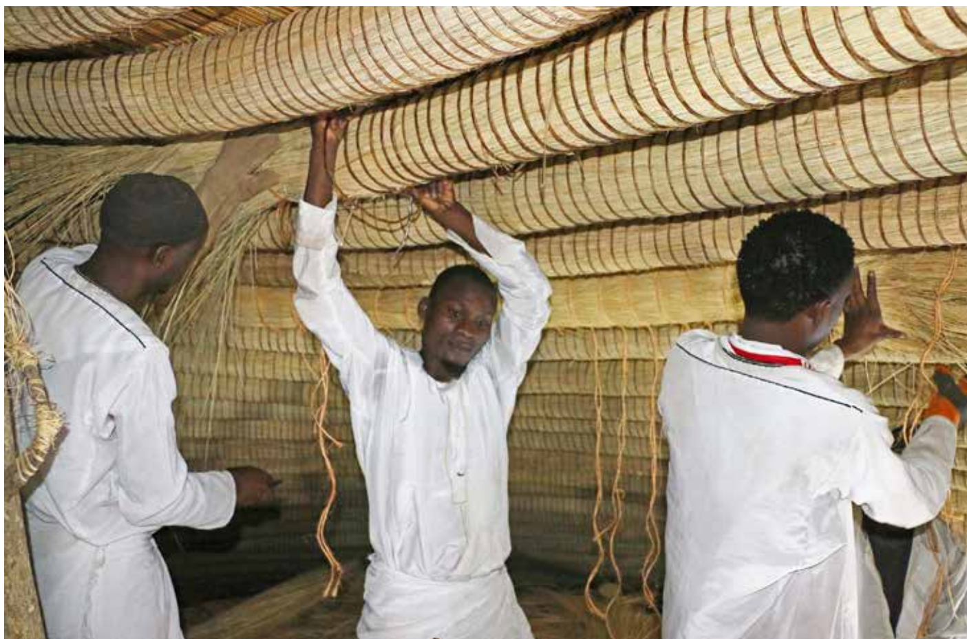
▼ Metiistoj instalas ringon el kanoj por subteni la pajlan tegmenton de unu el la konstruaĵoj en la loko.
