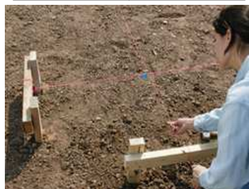
enplanta muntaĵo por teni liniajn fadenojn
