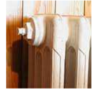
drenvalvo por radiatoro
