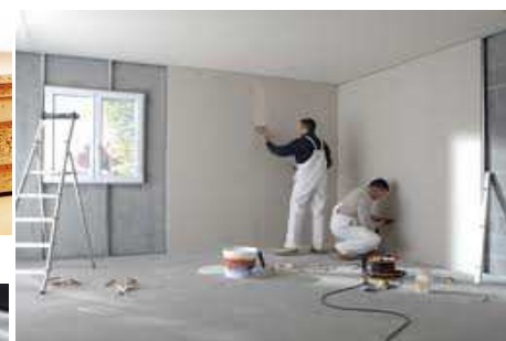
muntado da gips-paneloj sur rajloj
