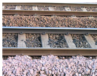
balasto sub trako (gruzo por bloki ŝpalojn)
