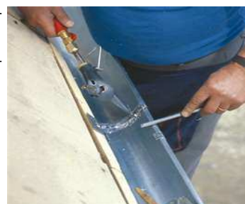
lutado sur pluvkanaletoj
