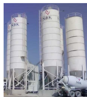
cementosiloj en porbetona centralo
