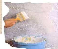
kalkaĵo sur muro
