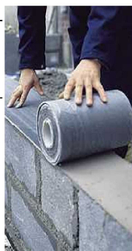
armita bitumo en muro
