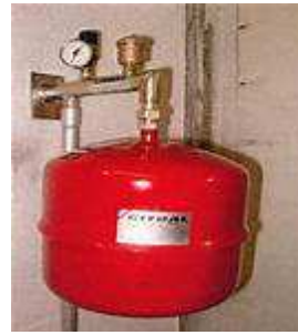
ekspansia vaso por hejtcirkvito
