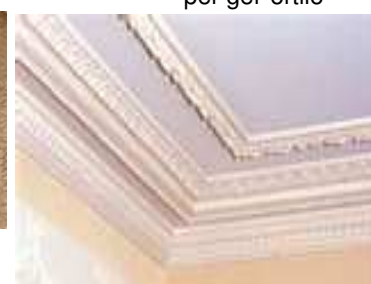
mulda gipsaĵo sur plafono
