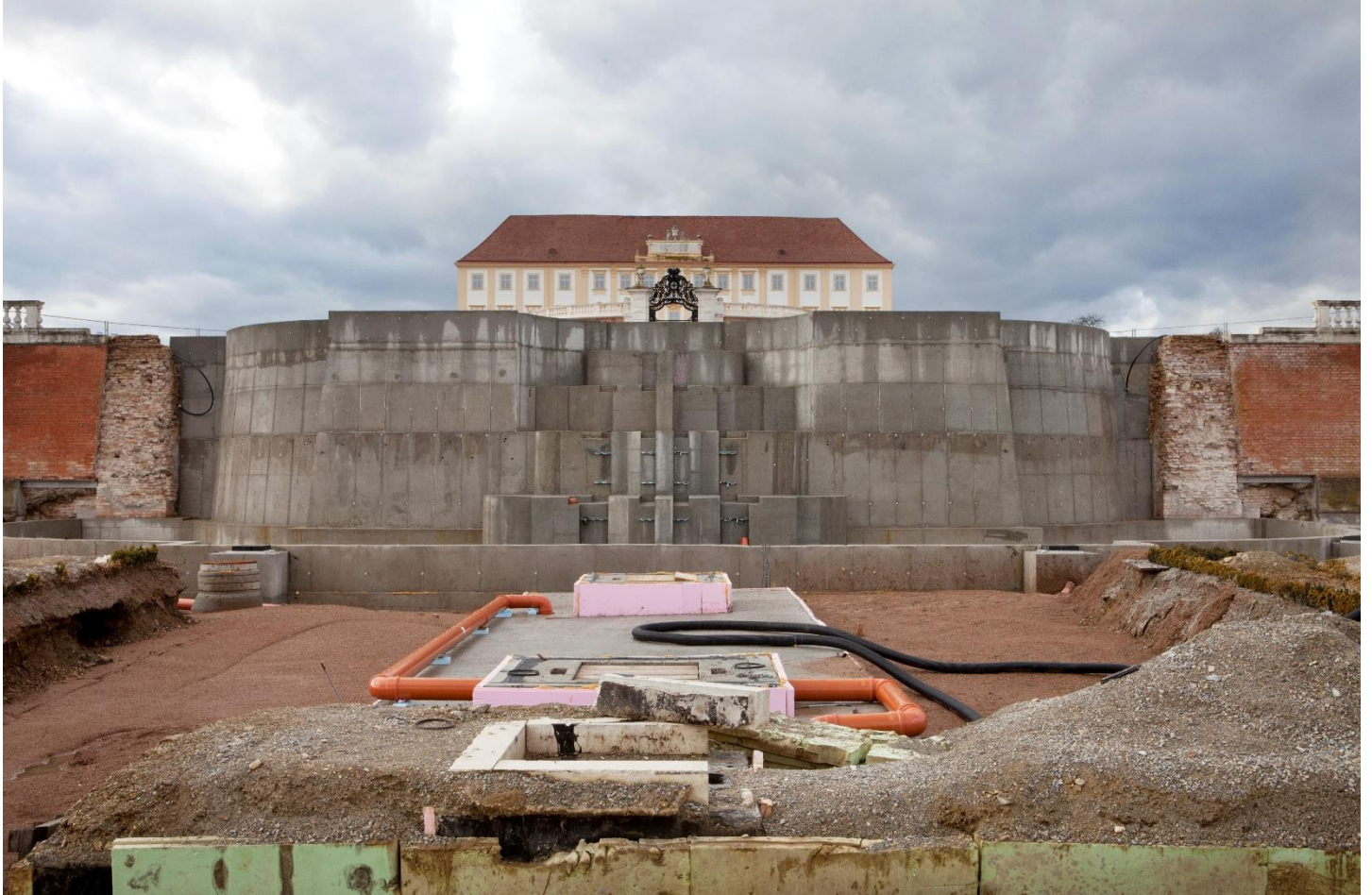
Betona muro okcidente de la suba baseno kaj instalaĵo por la funkciado de la akvofalo. Malantaŭ la betona muro situas la supra baseno, nevidebla sur la foto. © BDA Irene Dworak.
