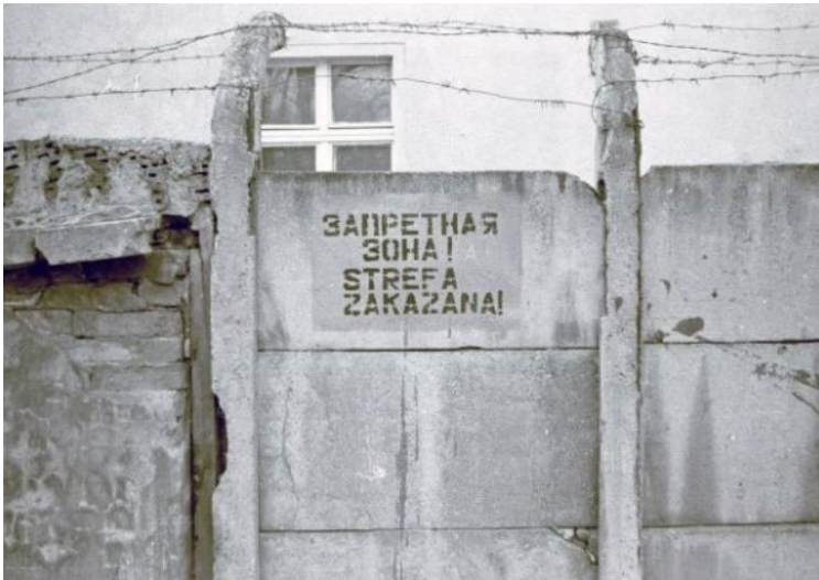
Muro en Legnica. Foto Grzegorz Spała
