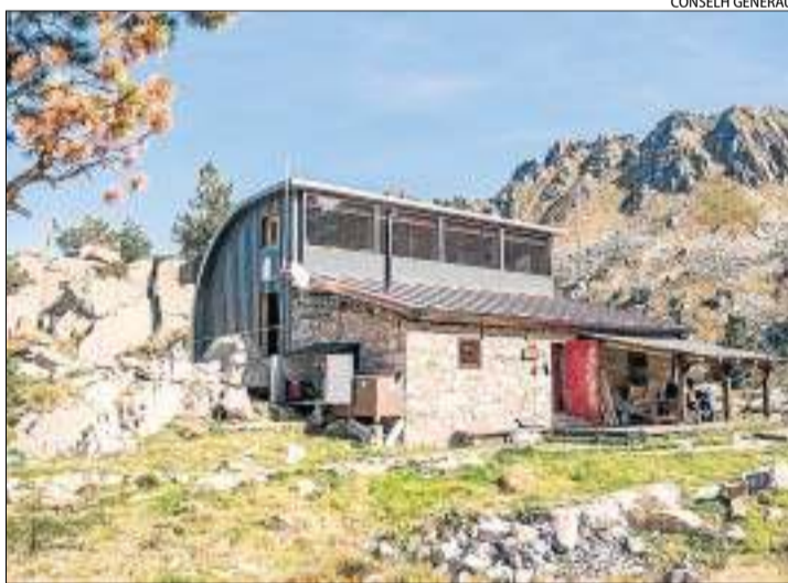
L'ampliació del refugi de Saboredó.
