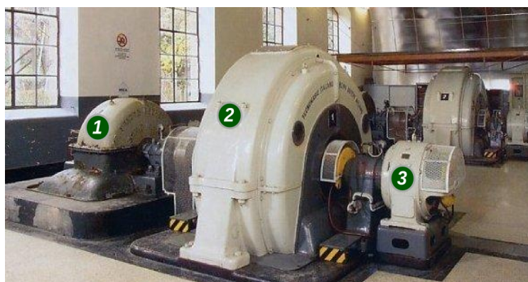
Fig. 186: 1) turbino - 2) generatoro - 3) ekscitanta generatoro
